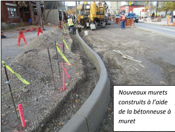
*Nouveaux murets construits à l'aide de la bétonneuse à muret*
