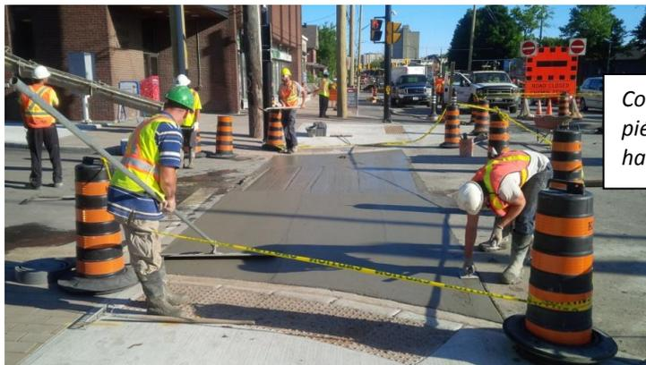
Construction du passage piétonniers en béton à la hauteur de la rue Hazel.
