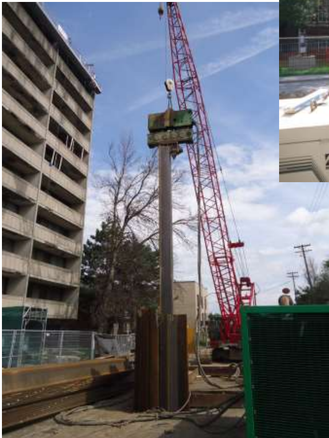
Installation d'un puits de sortie immédiatement au sud de l'avenue Lees
