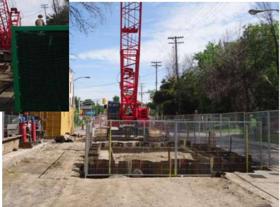
Installation d'un puits de sortie immédiatement au sud de l'avenue Lees
