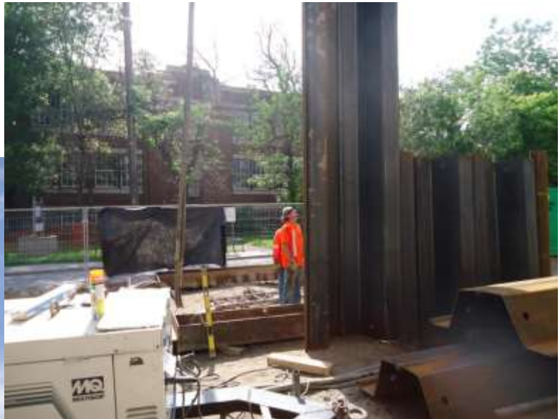
Installation d'un puits de sortie immédiatement au sud de l'avenue Lees
