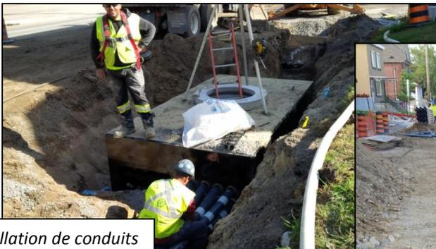
*Installation de conduits dans une chambre de raccordement*
