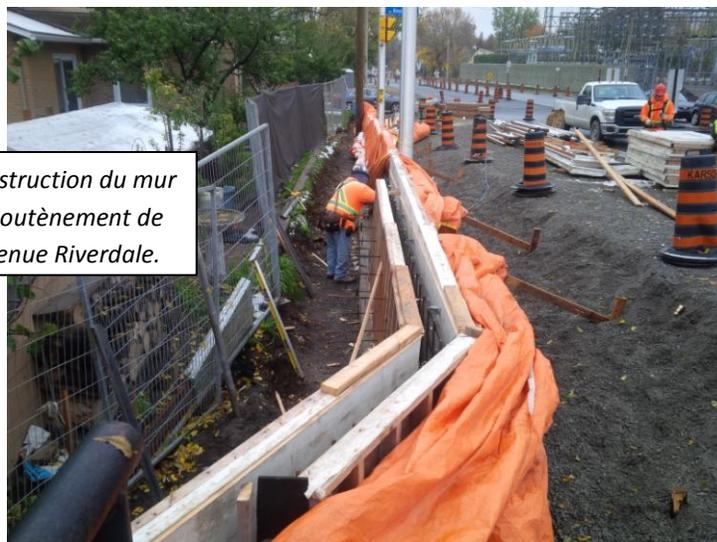
*Construction du mur de soutènement de l'avenue Riverdale.*
