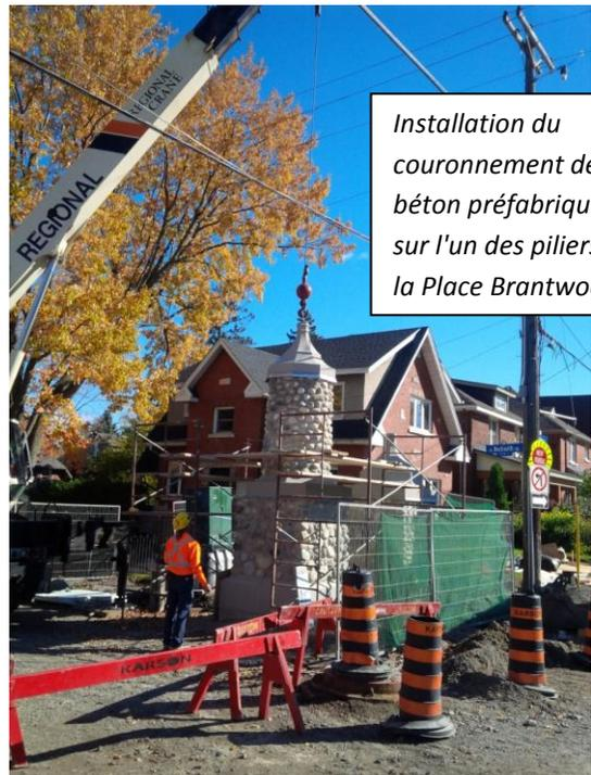
*Installation du couronnement de béton préfabriqué sur l'un des piliers de la Place Brantwood.*
