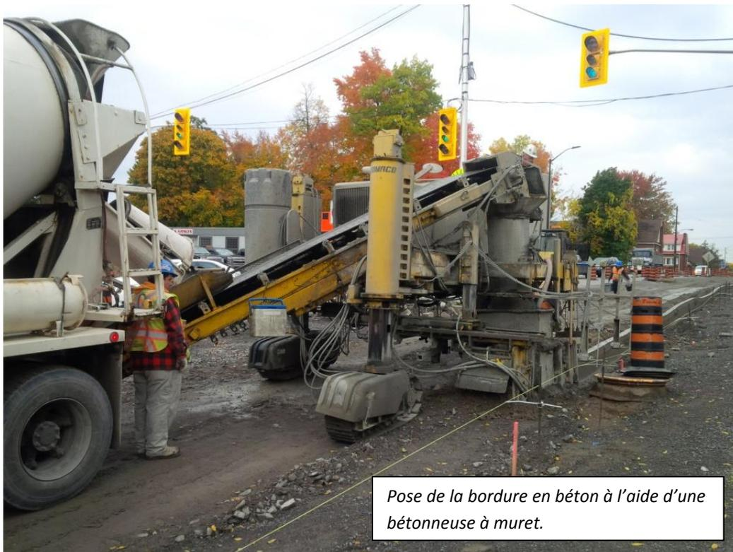
*Pose de la bordure en béton à l'aide d'une bétonneuse à muret.*
