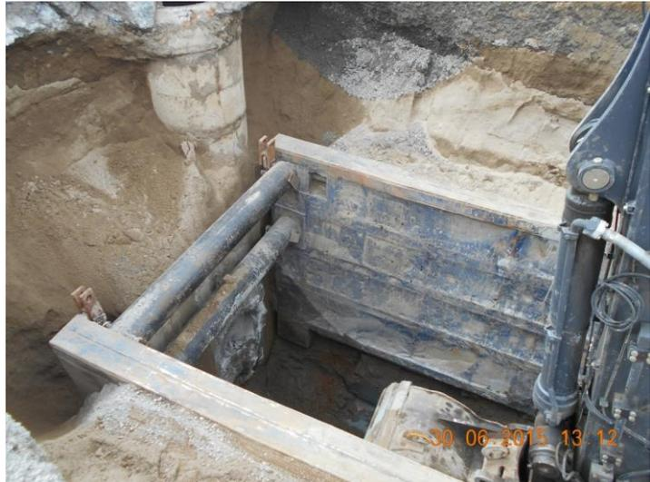
*Installation de l'égout pluvial de 1 200 mm de diamètre par tranchée à ciel ouvert*
