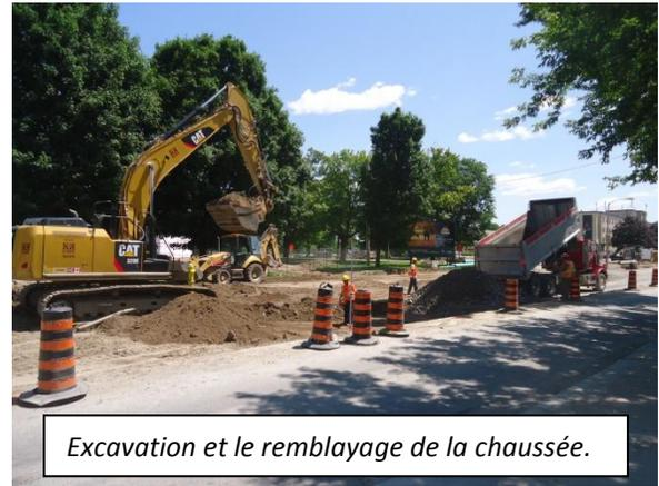
Excavation et le remblayage de la chaussée.
