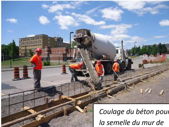
Coulage du béton pour la semelle du mur de soutènement.
