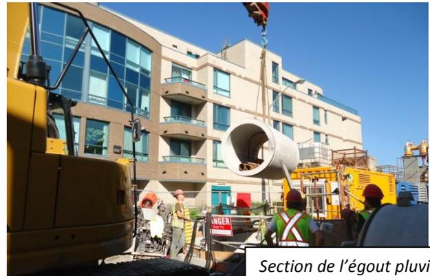
Section de l'égout pluvial soulevée au-dessus du puits de lancement.
