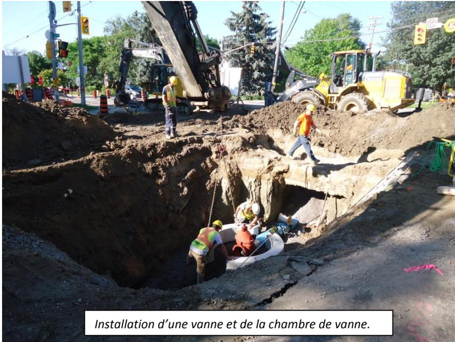
*Installation d'une vanne et de la chambre de vanne.*
