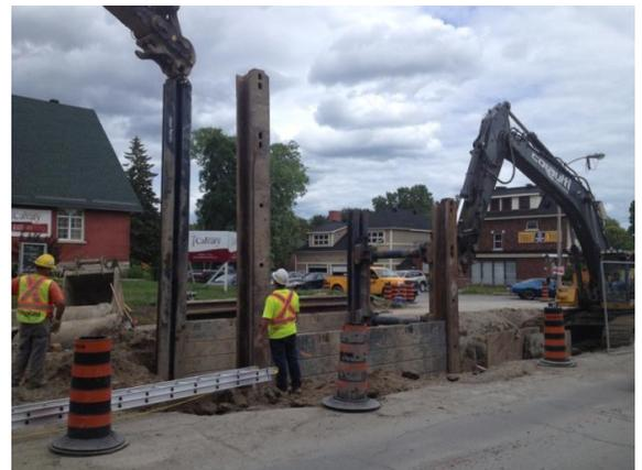
*Installation d'une boîte de tranchée permettant de travailler sur la conduite d'égout pluvial qui se trouve à une profondeur de 5 m.*
