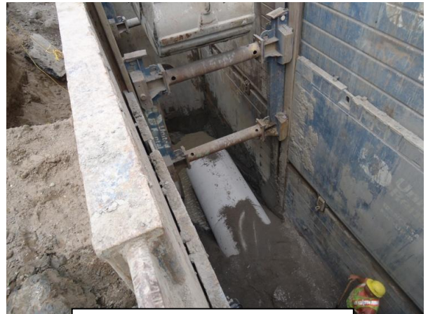
Installation d'un égout pluvial de 1 200 mm de diamètre dans une tranchée à ciel ouvert (d'environ six mètres de profondeur).
